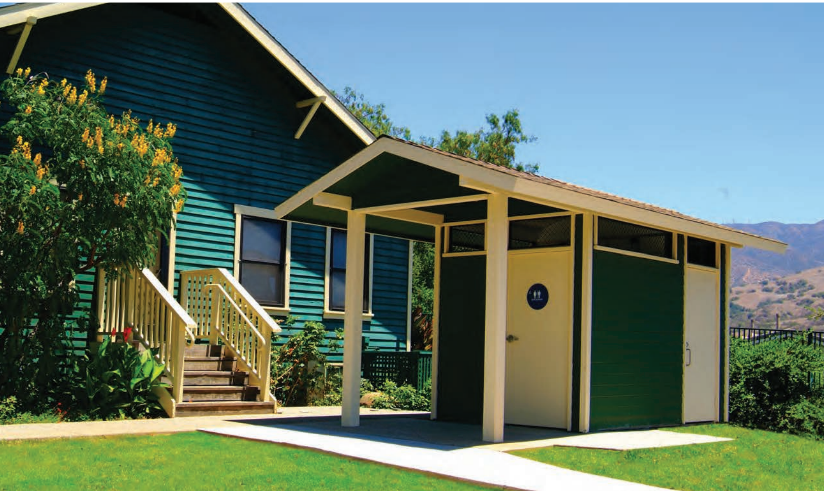
Instalación de baño prefabricada
