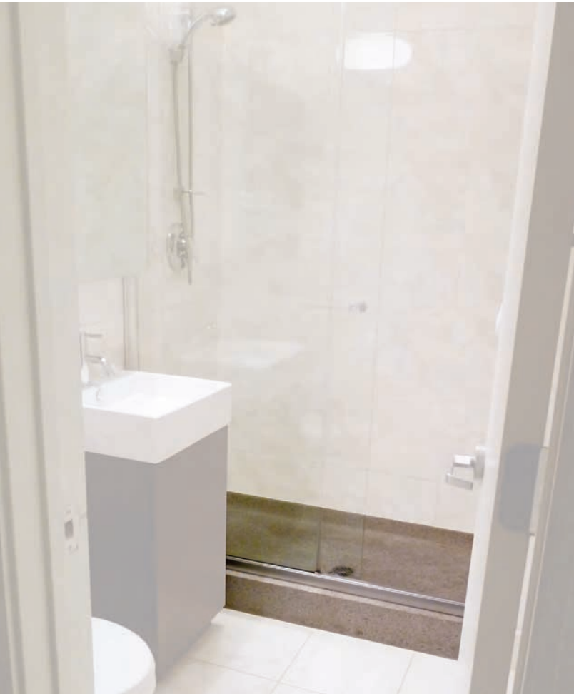
Los modelos con umbral de entrada integrado permiten la instalación de una puerta de ducha (instalación en un hotel de Nueva York)
