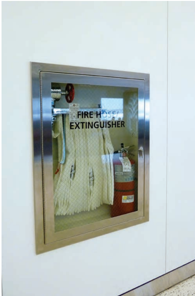
Puesto fijo empotrado con manguera y extintor de incendio
